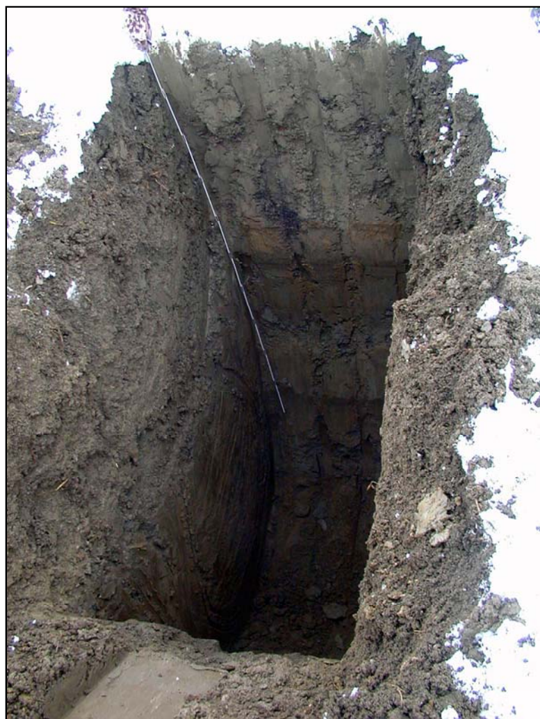
FOTO 3 - Particolare trincea n. 2.
