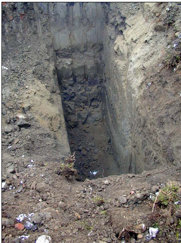
FOTO 1 - Dettaglio trincea esplorativa n. 1.
