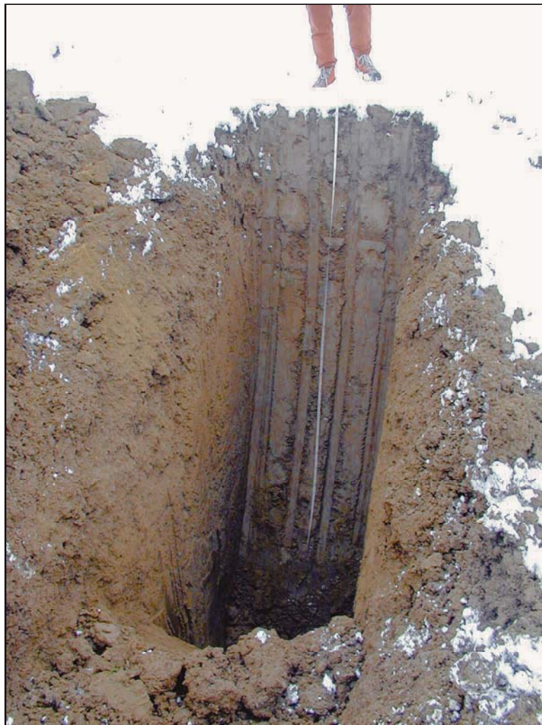
FOTO 7- Particolare della trincea n. 4
