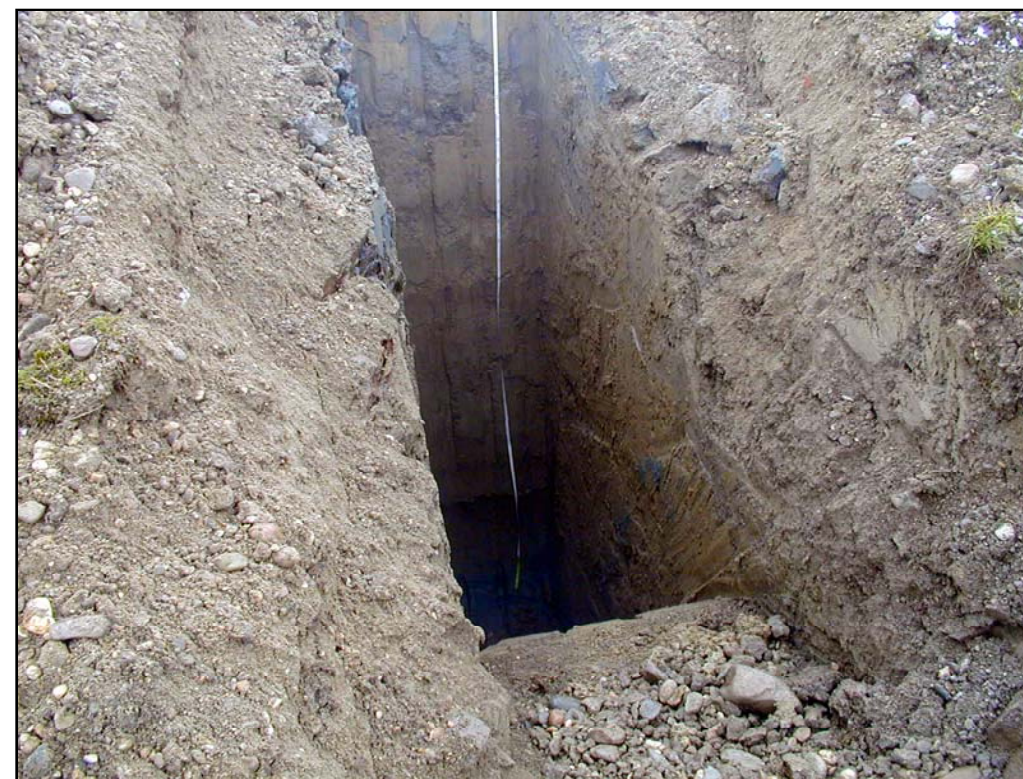
FOTO 4 - Particolare trincea n. 3.
