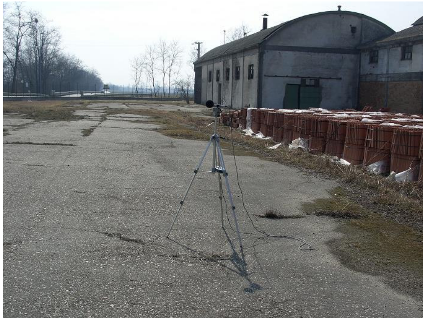
Fotografia n.4: Zona fornace dismessa.
